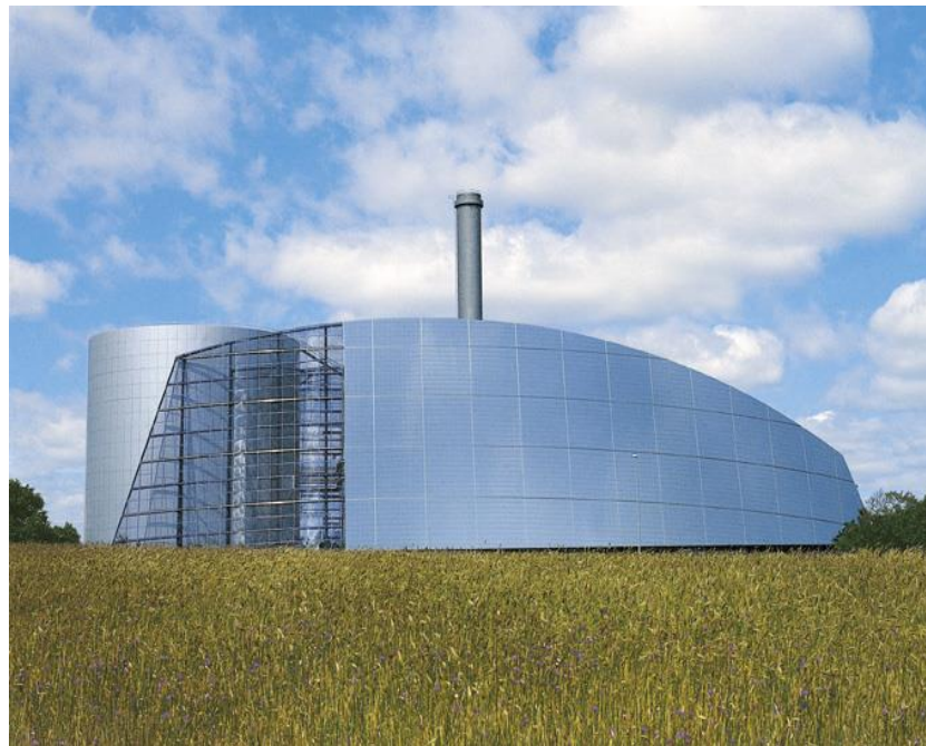
Теплостанция Виборг, Швеция
