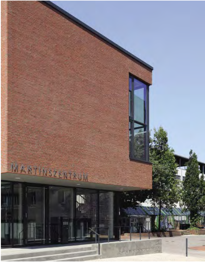
MARTINSZENTRUM, BOTTROP FEJA + KEMPER ARCHITEKTEN, RECKLINGHAUSEN
