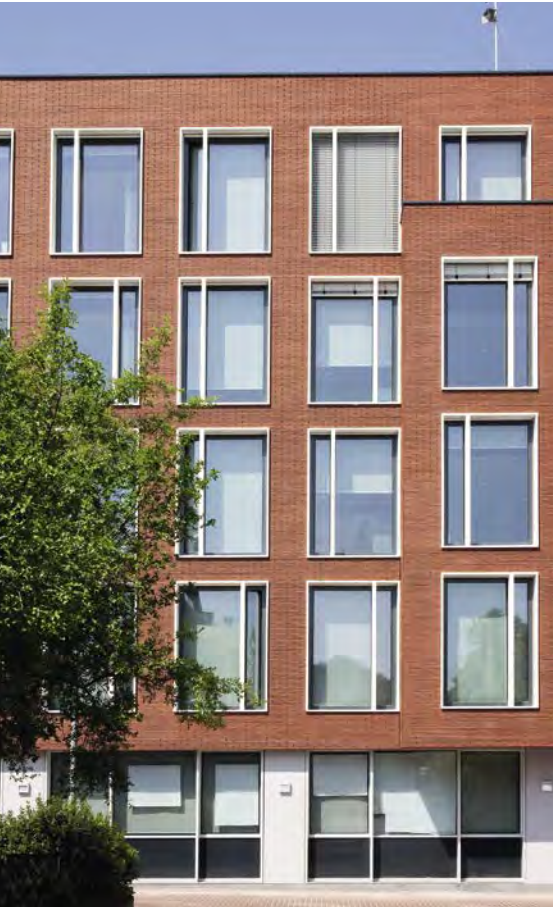
PROVINCIEHUIS NOORD-HOLLAND, HAARLEM, NL KRAAIJVANGER ARCHITECTS, ROTTERDAM
