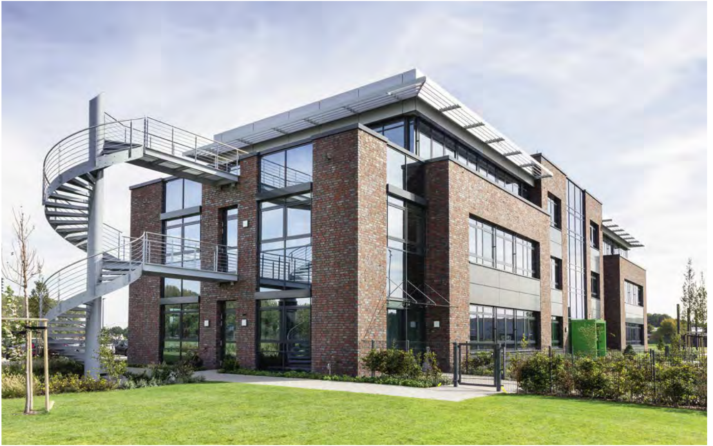
VERWALTUNGSGEBÄUDE ELO EG, VECHTA-LANGFÖRDEN SHI PLANUGSGESELLSCHAFT, OLDENBURG
