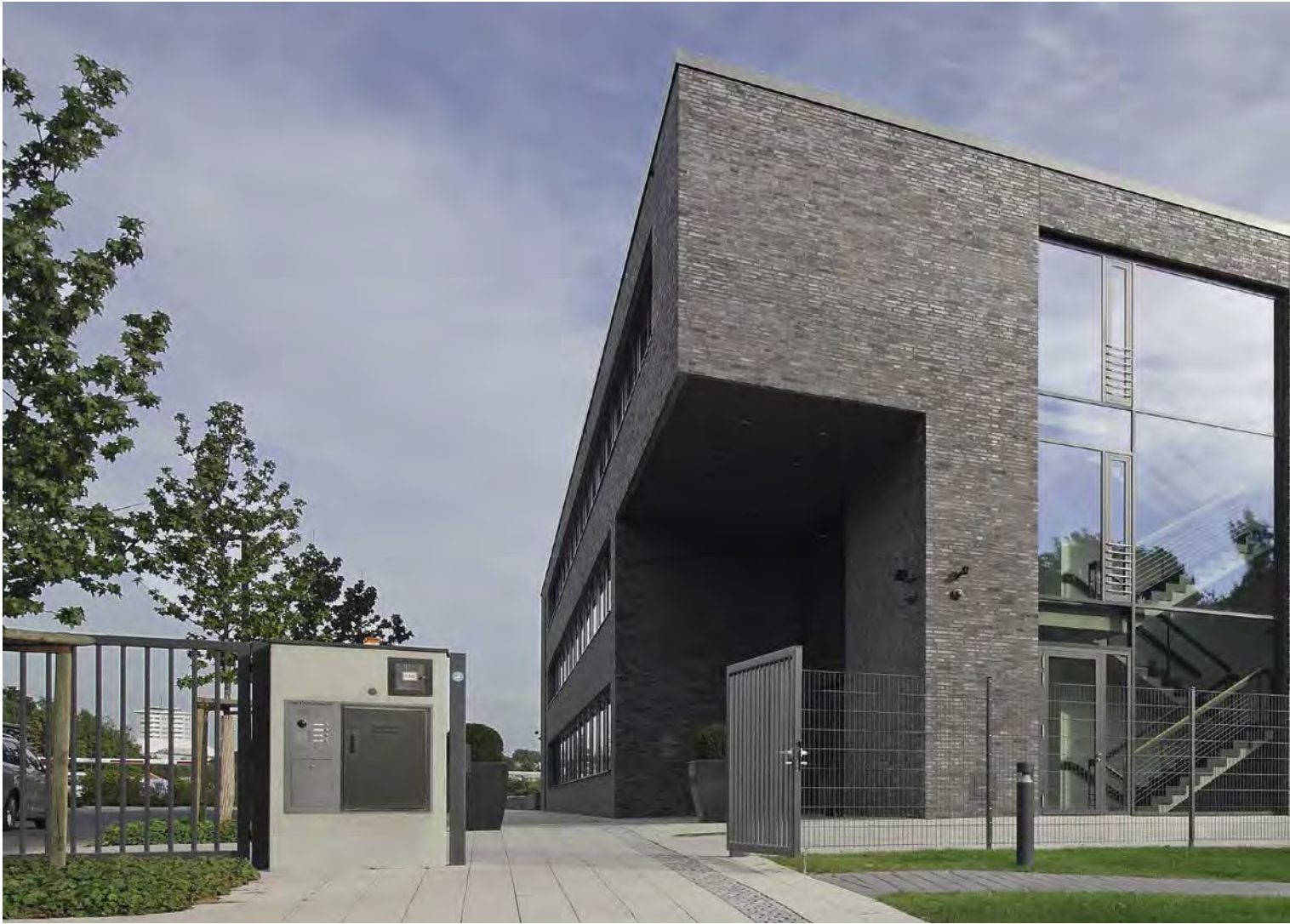
TECHNISCHE BETRIEBE, VELBERT FEJA + KEMPER ARCHITEKTEN, RECKLINGHAUSEN
