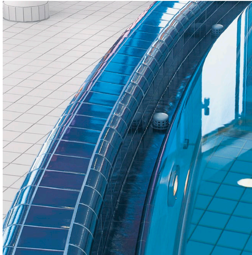
Терапевтический бассейн, Ланген-Добштедт, Германия Архитектор: Westphal u. Partner Architekten, Бремерхафен, Германия / Фото: Файт С. Мюллер, Гамбург
