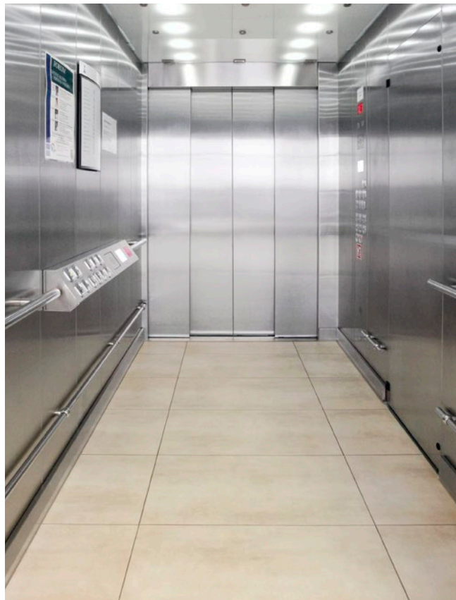
Больница Св. Иосифа, Гисен, Германия / Архитектор: lucas architekten GmbH / Фото: Йохен Штюбер
