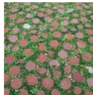
Pfasterfuge - gebunden mit Fugenmörtel und umwelttoffen als begrünte Fuge
