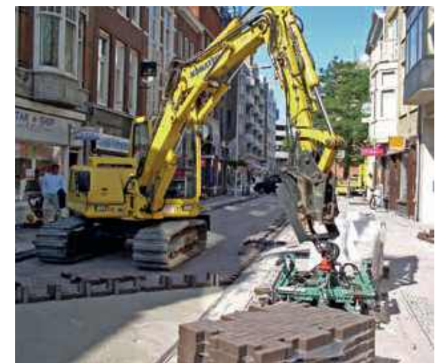
Maschinenverlegung von Pflasterklinker, Den Haag, Niederlande
