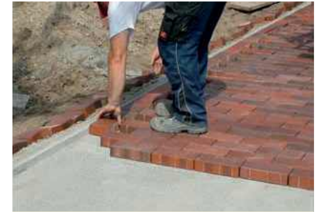
Abb. 5-11: Handverlegung von Pflasterklinkern
