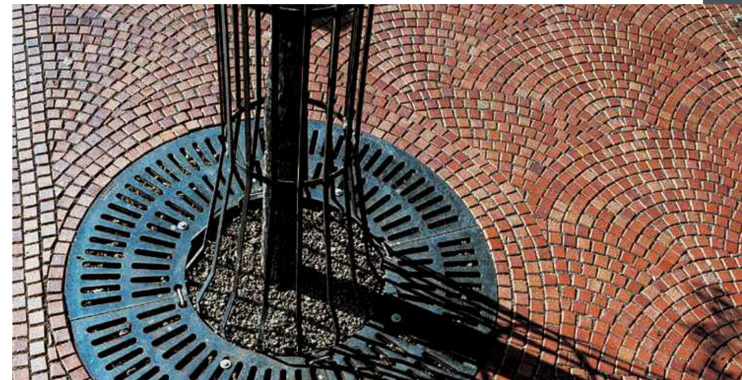
Einfassung von Einbauten mit Mosaikklinkern (Segmentbogenpflaster)
