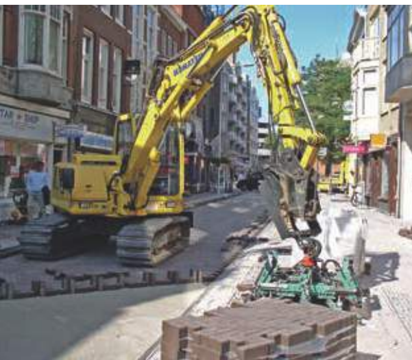
Maschinenverlegung von Pflasterklinker, Den Haag, Niederlande
