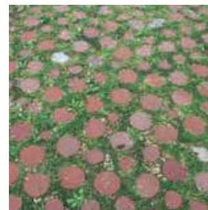
Pflasterfuge - gebunden mit Fugenmörtel und umwelttoffen als begrünte Fuge
