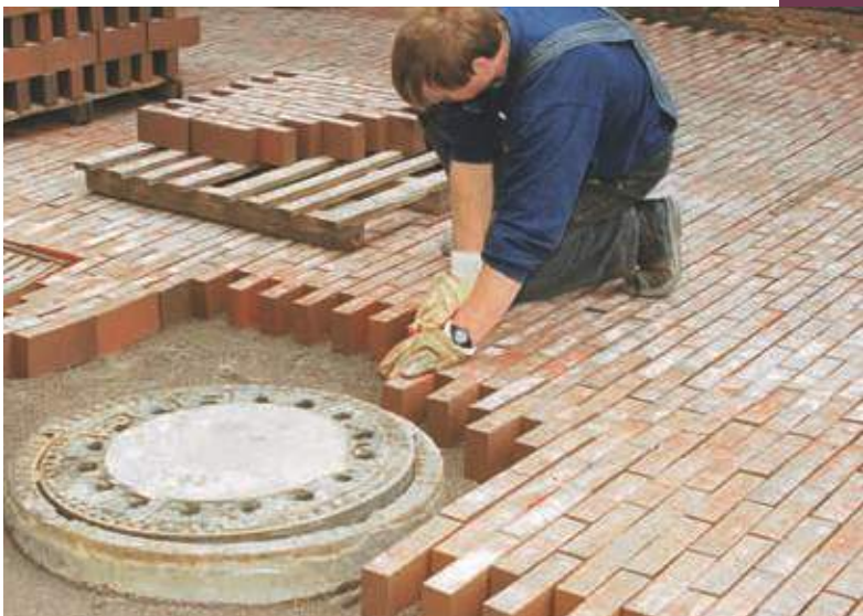
Anpassen von Pflasterklinker an Schachtdeckel und Einläufe (Einbauen)
