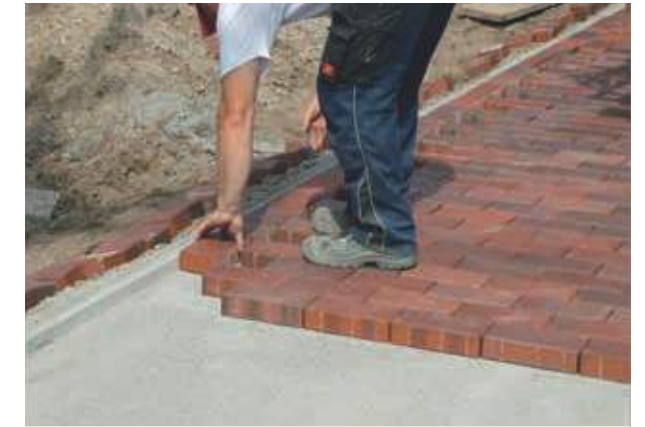
Abb. 5-11: Handverlegung von Pflasterklinkern
