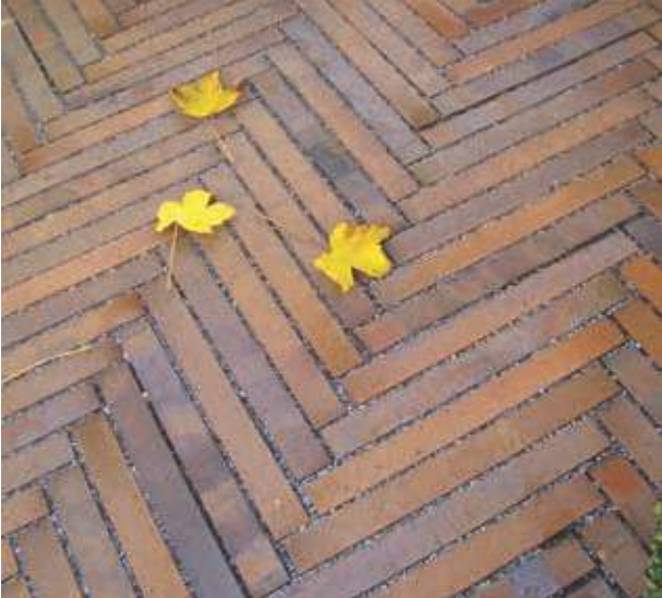
Pflasterklinker als Langformat verlegt im Fischgrätverband
