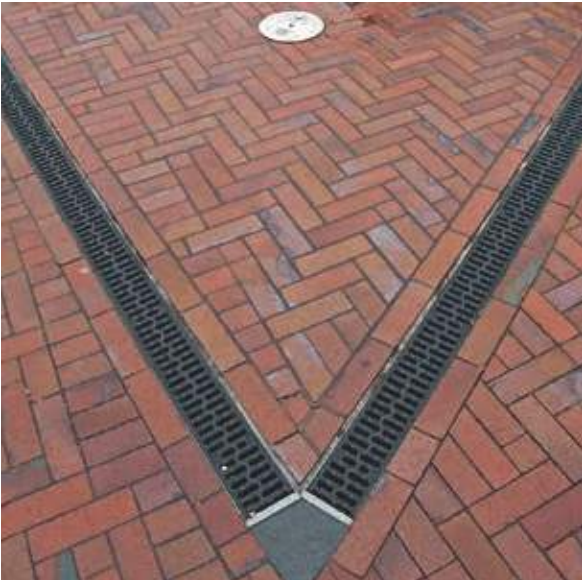
Abschlussdetail – Entwässerungsrinne, Barsinghausen, Deutschland
